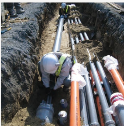
電線共同溝(一般部分)での配管
