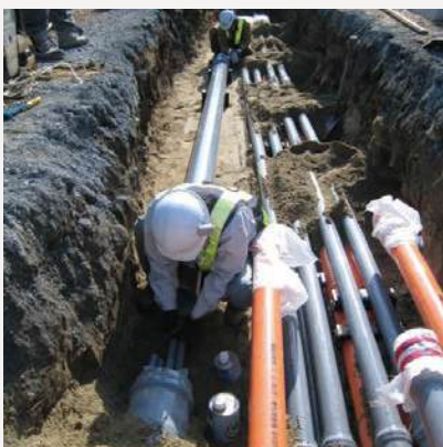
電線共同溝(一般部分)での配管
