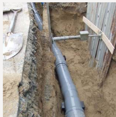
水道管の下越ししなからの障害物回避配管
