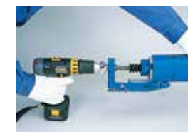
管端のスクレープ
