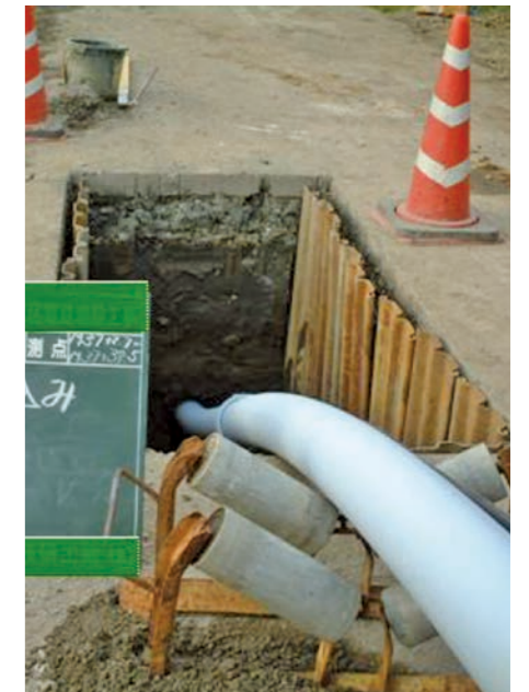
推進工事 (HDD 工法)
