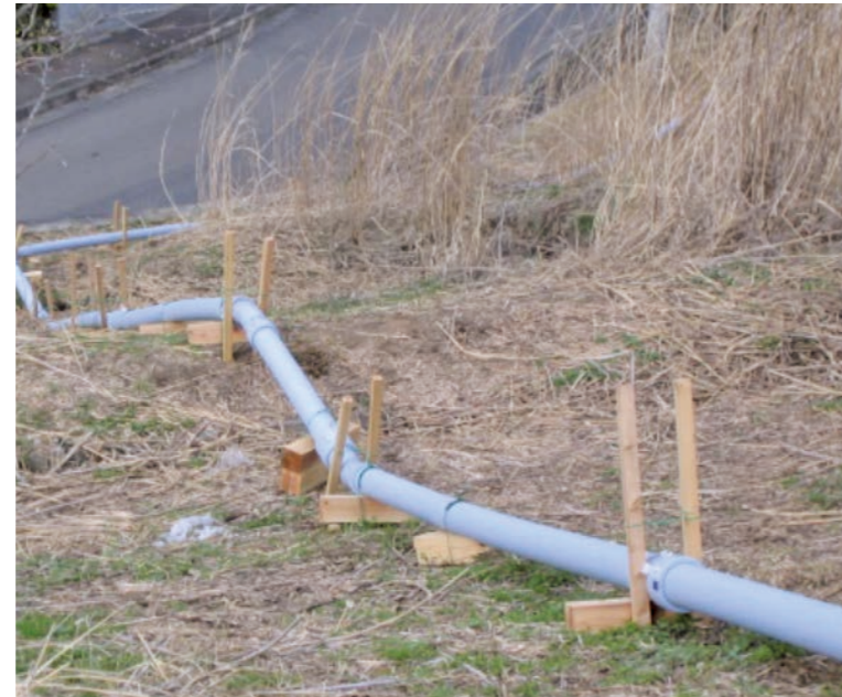
仮設配管 (震災復旧)
