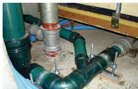
■改修(横枝管は従来管と接続)
