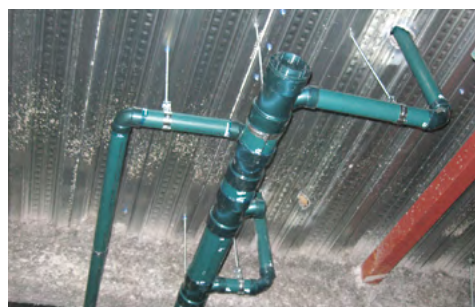
■新築(天井部の排水管)
