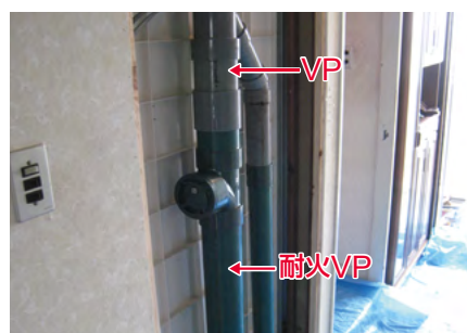
■改修 (区画から1m以降の立て管は従来管と接続)
