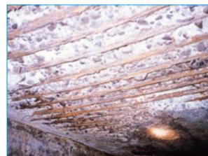
●既設管の腐食状況(矩形)
