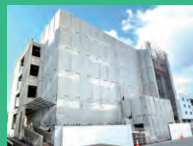
国立大学法人 名古屋工業大学 「排水配管改修」
