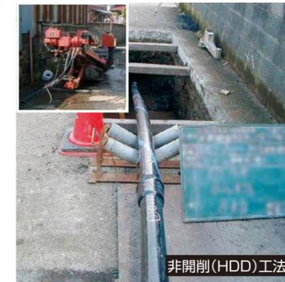
非開削(HDD)工法
