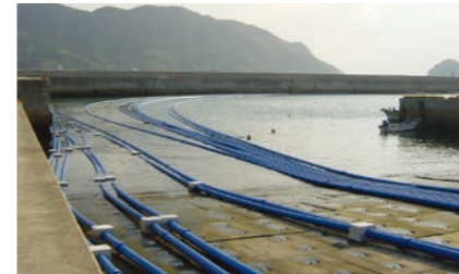
海洋深層水取水(海底配管)
