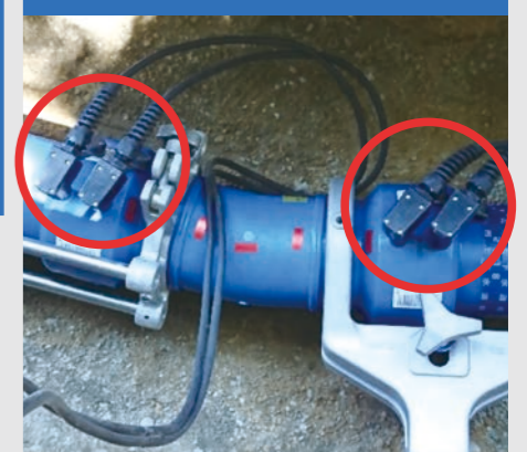
EF両受バンド 同時通電施工事例
