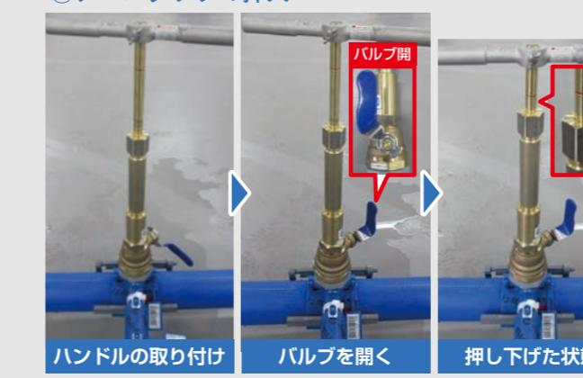
1) 挿入機にハンドルを差し込み、蝶ネジで固定してください。
