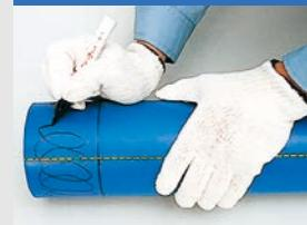
削り残しや切削ムラの確認を容易にするため、管端から挿入標線までの切削面を油性ペン等でマーキングします。
