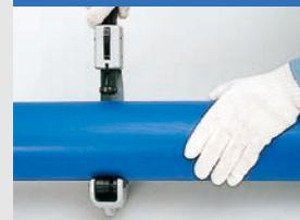
パイプカッターや電動のこ(ハイパーソー)を用いて、管軸に対して直角に切断します。
