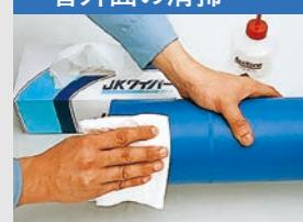
アセトンまたはエタノール(95%以上)を浸み込ませたペーパータオルを使用して融着面(管の切削面・継手内面)を清掃してください。
