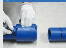
管に継手を奥まで挿入し、EF継手端部を利用して再度挿入標線を記入します。
