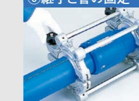
1)継手に双方の管を標線位置まで挿入します。
