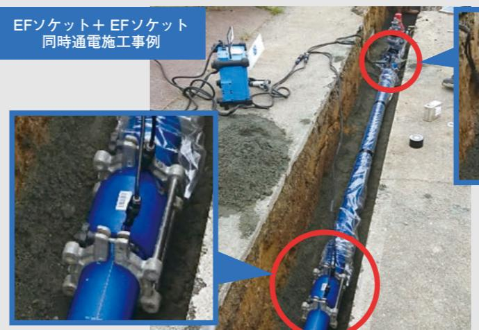
③EFコントローラケーブルと同時通電専用ケーブルの接続
