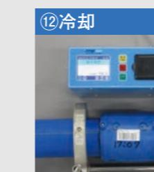
1)融着終了時刻に冷却時間を加えたクランプ取り外し可能時刻を継手表面に油性ペン等で記入してください。
