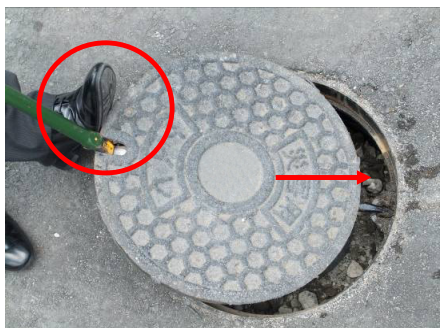
20. 足でマンホールを 閉塞定位置まで押し込む
