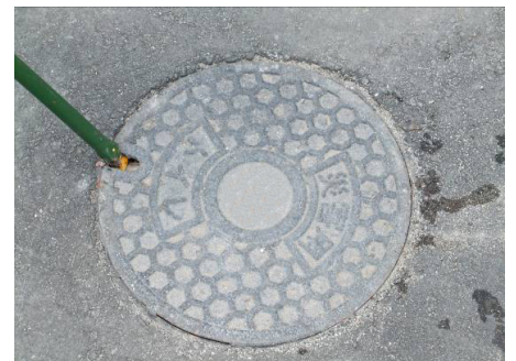
21. マンホール蓋を下ろし、 注水口の閉塞完了
