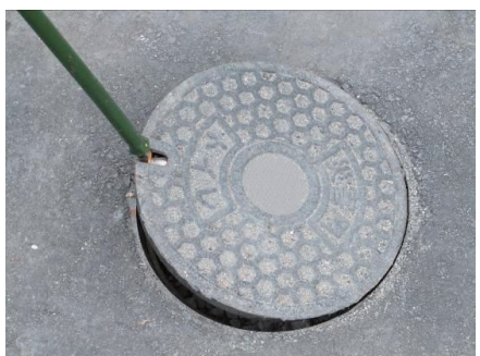
7. マンホール蓋を引上げる
