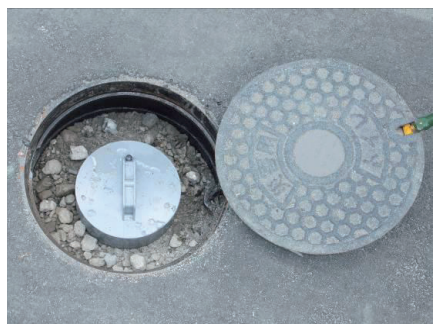
10. 写真のような状況に マンホール蓋を置く
