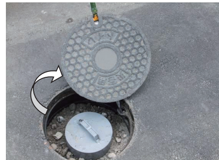
9. マンホール蓋を回転させる
