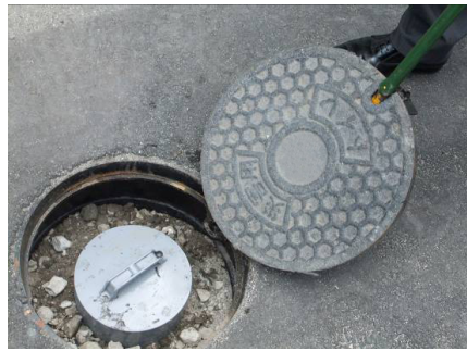
17. 注水口のマンホール蓋ロック部に ボールを差込む
