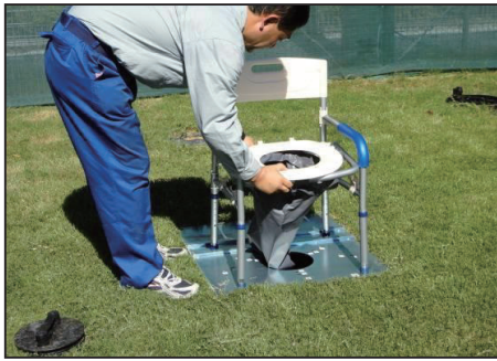
4-3. 便座内部に便器設置
