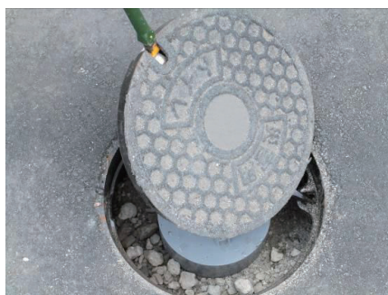
8. マンホール蓋を引上げながら 回転させる
