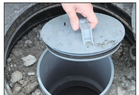
12. 塩ビ製内蓋の取っ手を持ち、 引上げる
