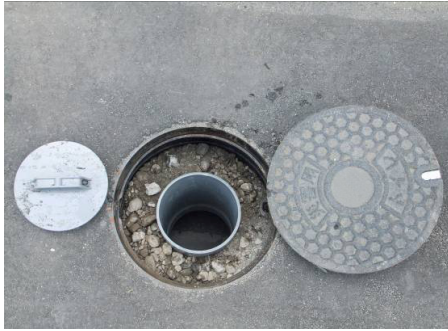
13. 注水口のマンホール蓋開孔完了
