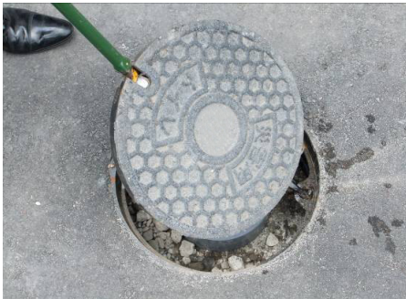
19. マンホール蓋を回転させる
