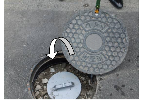
18. マンホール蓋を上げながら 回転させる
