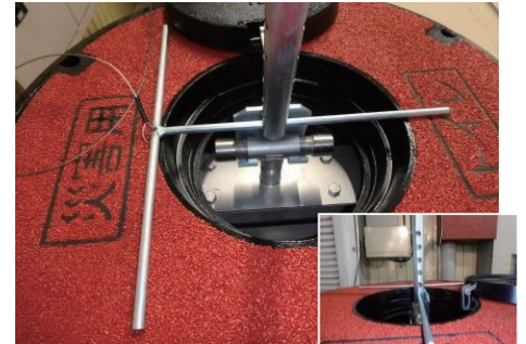
9. 開閉治具の穴にストッパーを差込み汚水 が全て流れきるまでその状態を維持する
