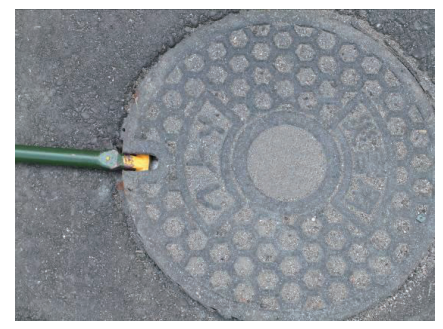
6. 硬くなっているマンホール蓋を 動かす
