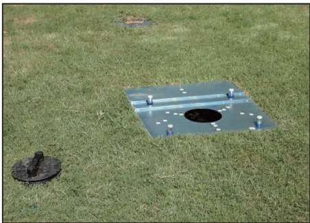
4-1. 鉄蓋部分に台座設置
