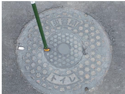
2. パール差込部を水平にして 子蓋ロック部に差込む
