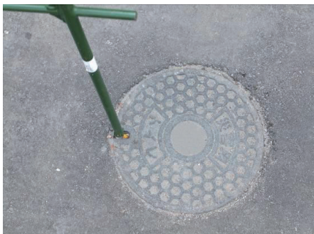
4. パール差込部を水平にして マンホール蓋ロック部に差込む
