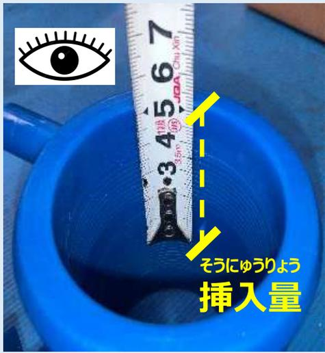
各呼び径の挿入量
