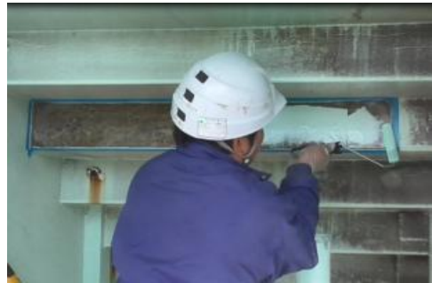
【例】 図 4. 5. 21 鋼構造物塗布状況
