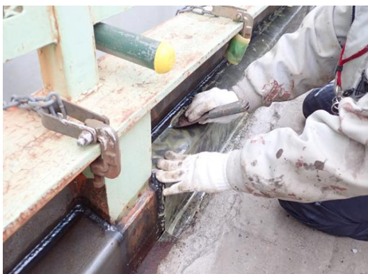
図 4.5.11 脱泡作業状況(左が鋼構造物 右がCo 構造物)
