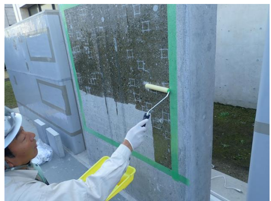
図 4. 5. 4 ベースプライマーの塗布状況 (左が鋼構造物 右が Co 構造物)
