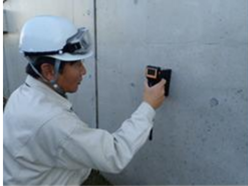
図 4. 5. 3 コンクリート水分量の計測状況
