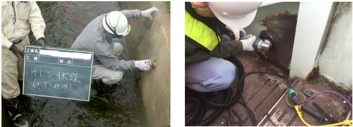
図 4.5.1 ケレンの状況（左図：Co 構造物、右図：鋼構造物）
