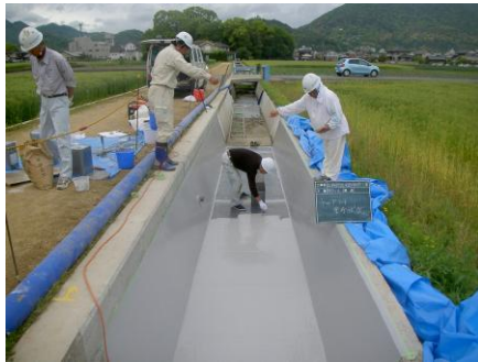
【例】 図 4. 5. 20 Co 構造物塗布状況
