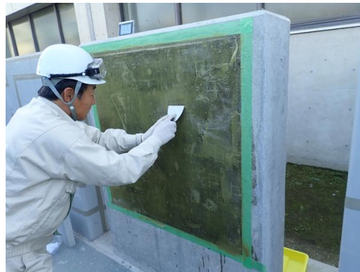
図 4.5.11 脱泡作業状況(左が鋼構造物 右がCo 構造物)
