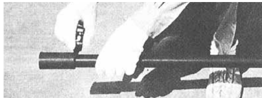
写真-6 挿入長さゼロポイントの確認
