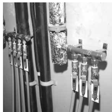
さや管ヘッダー式配管システム
