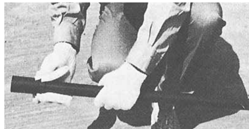
写真-5 清浄処理
