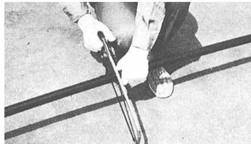
写真-3 パイプの切断
