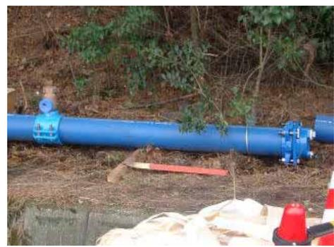
栓帽を取り付けた後、分水栓から、エアバック、挿入機を取り外し、作業完了です。
