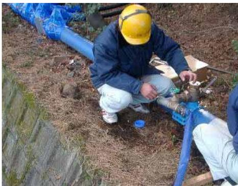
分水栓に水圧計を取り付け、水圧を確認。
