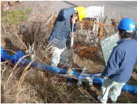
分水栓にエアバックを取り付けた挿入機を設置。上部より、人力で本管内にエアバックを挿入、管内で膨らませて、止水します。
