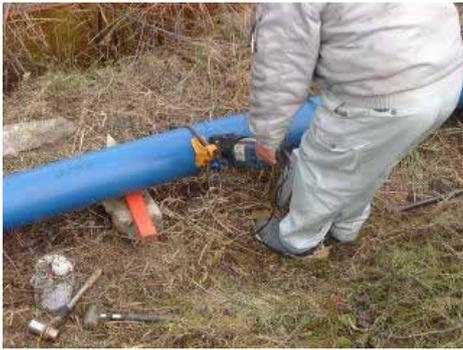
エアバックによる止水を確認した後、切り回し区間の管を切断します。
