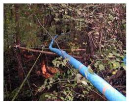
接合した長尺管をウインチで引き上げ、布設場所へ。柔軟性を生かして、木々をかわして行きます。
