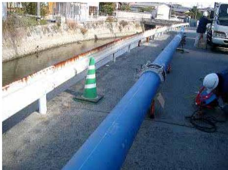
水道配水用ポリエチレン管は、事前に融着接合を完了。長尺管35mを作成しました。
