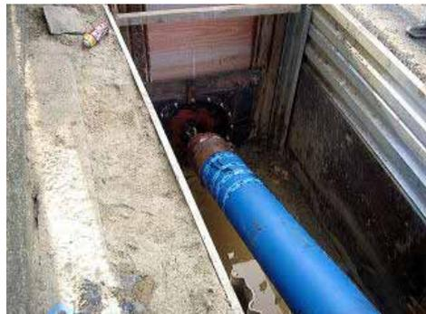
立坑に到達したドリルロッドに、リーマー、ポリエチレン管を順番に接続。リーマーから水を噴射させながら引き込みを開始します。
