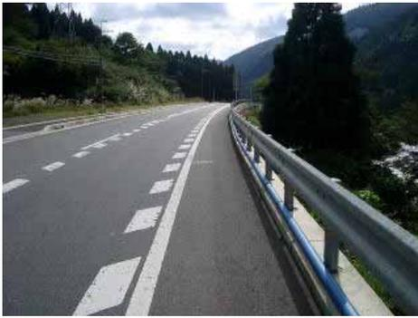
ポリエチレン管の柔軟性を生かし、道路に沿って、生曲げで配管を実施。曲がりくねった道で威力を発揮する。
