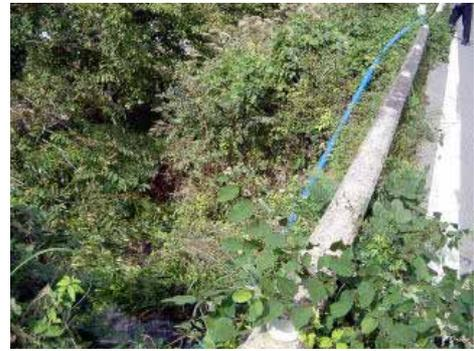
作業性の悪い区間では、先に接合した長尺管で配管。重量は約10kg/5mで、長尺管(15m)も数人で小運搬が可能。
