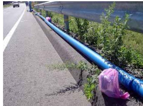
配管資材は路側帯に並べ、順次融着作業を実施。融着班は最大5班とし、固定金具(クランプ)は、各班4個ずつ準備。
