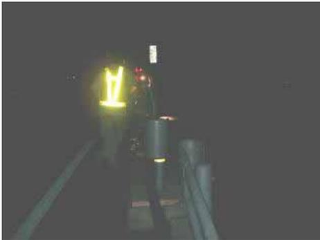
夜間の配管作業は、投光器を設置して実施。また、警備員による交通誘導を行い、作業員も反射材を着用するなど事故防止を徹底。
