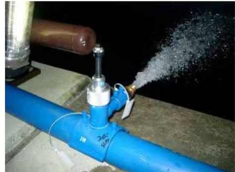
配管終了後、通水試験を実施。接合箇所は、250箇所以上に及んだが、いずれも漏水なく、EF接合の信頼性の高さを改めて実感。
