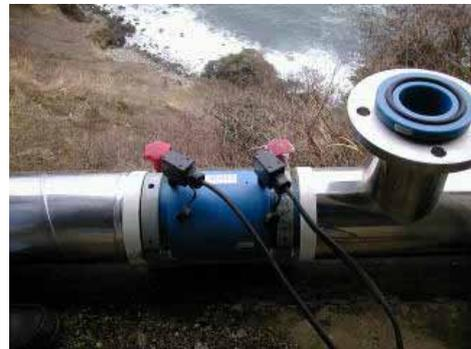
足場の悪い条件でも、EFソケットで確実に接合。作業性が向上します。
