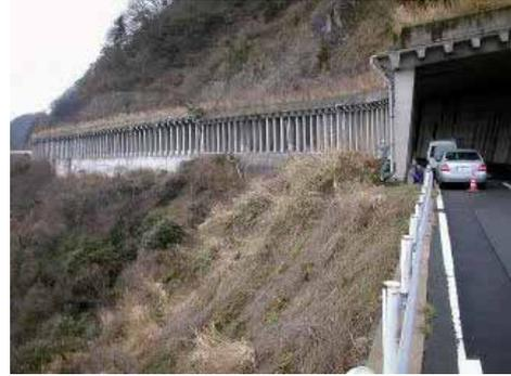
エスロハイパー被覆管は、スノーシェイド部の露出配管に使用。外面コンクリート部に設置します。
