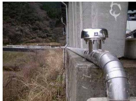
空気弁部は、被覆付フランジ付チーズG形を使用。不凍急排形空気弁 [前澤工業製] を設置し完了。
