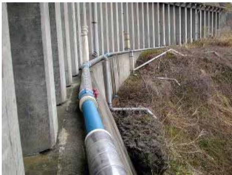
微妙な寸法合わせは、調整用の乱定尺管で対応。被覆部が取り外せ、現場で切管調整が可能です。
