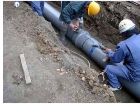
エスロハイパー布設に先立ち、硬質塩化ビニル管300Aを鞘管として布設。
