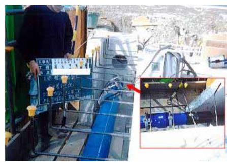
末端部分には、鋳鉄管用継手(変換継手)を使用しました。
