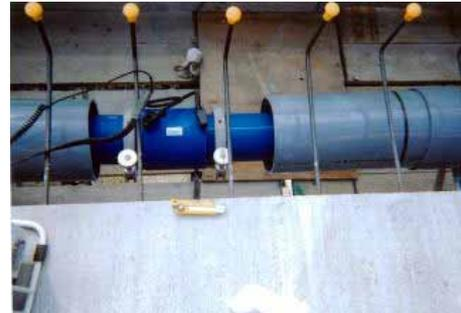
挿入標線まで、ソケットを戻して融着開始。突き合わせ配管時に有効です。
