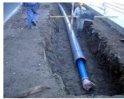
エスロハイパーは、軽量かつ離脱防止が不要。長尺管を一気に挿入・配管完了です。
