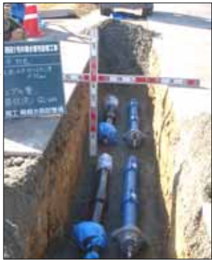
図2 公道下埋設状況
