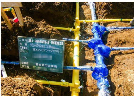
青ポリ給水管の採用事例（習志野市）
