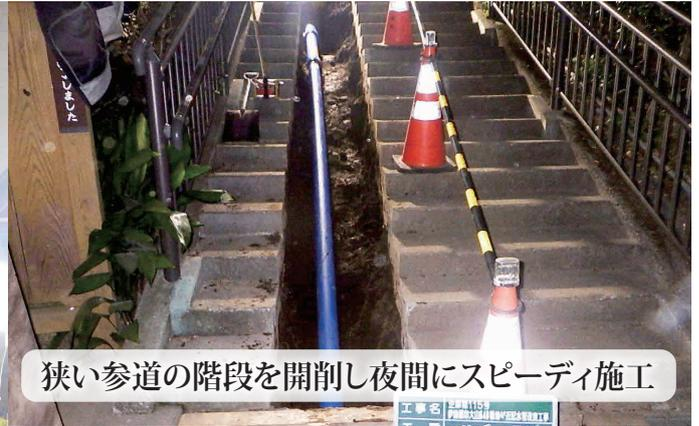
EFプラグ付サドルの施工(給水配水一体化)
