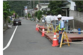
図-3 発進坑遠景
