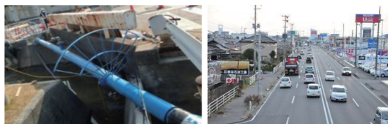
写真1 開削困難箇所（橋梁添架管、国道横断部）
