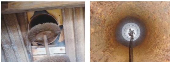
写真3 ワイヤーブラシによる管内清掃
