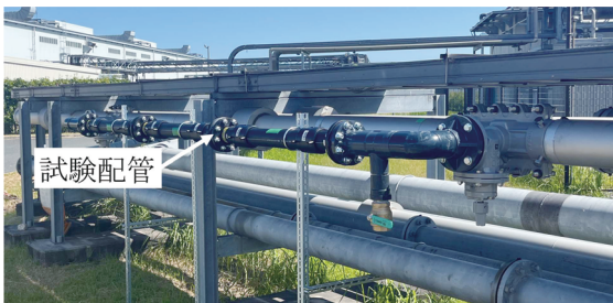
写真3 既設配管に導入した試験配管
