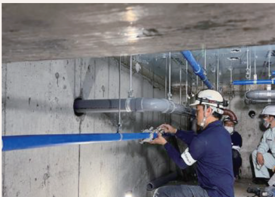
写真4 EF受口付直管の施工状況
