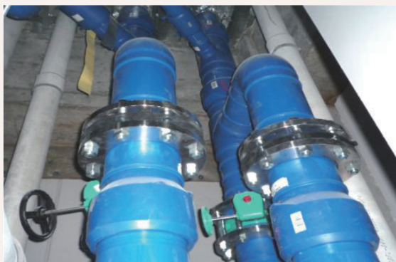
写真7 病院での配管例（冷却水管）
