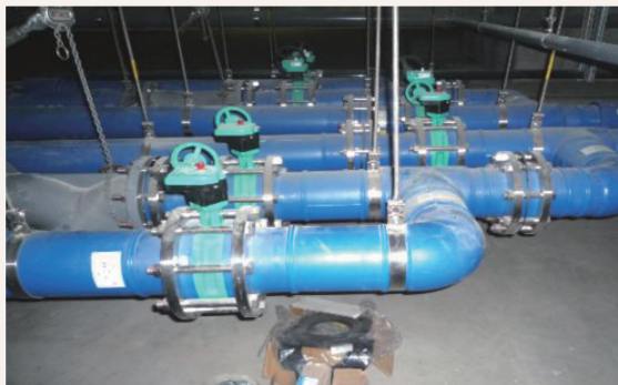
写真6 事務所ビルでの配管例（給水管） ※赤囲いはプレハブ加工、緑囲いは定型加工品での配管を指す
