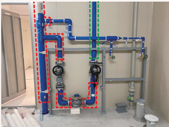
写真6 事務所ビルでの配管例（給水管） ※赤囲いはプレハブ加工、緑囲いは定型加工品での配管を指す
