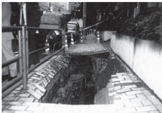
第2図 下水道劣化に起因する道路陥没の例 (出典：東京都下水道局HPより)
