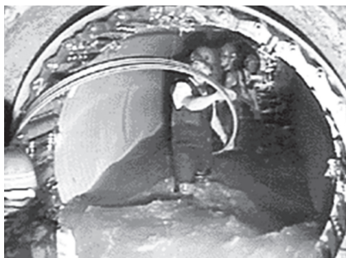
第6図 下水供用下での施工事例
