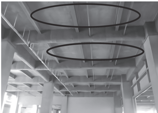
写真1 パックスフレームを天井面に吹き付けた様子
