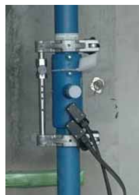
写真 4 融着施工例
