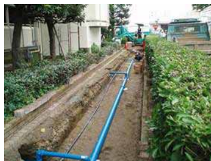
写真7 敷地内埋設配管例
