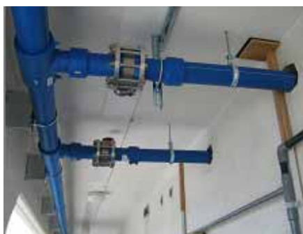
写真9 外廊下の配管 (配管カバー設置前)
