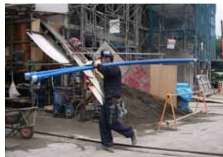
写真 3 小運搬の実例
