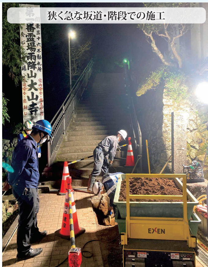
狭い参道の階段を開削し夜間にスピーディ施工
