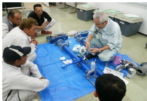
施工実演・講習
