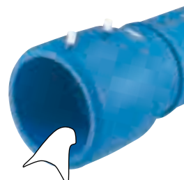
継手内面の清掃
