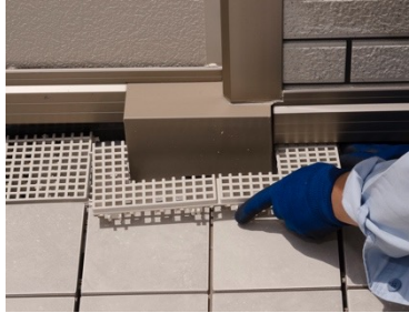
スキマの大きさに合わせて 切断した幅調整材を差し込む。
