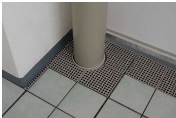
排水パイプのまわり
