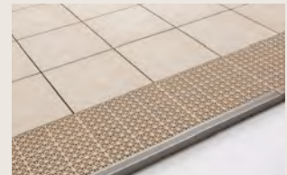
端部カバー材とP4ネット併用納め
