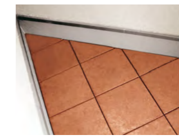
変形のバルコニーの端部
