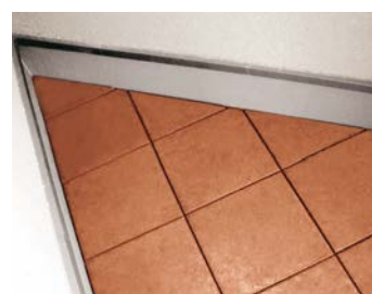
変形のバルコニーの端部
