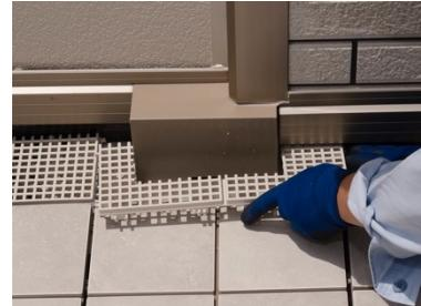
スキマの大きさに合わせて切斷した幅調整材を差し込む。
