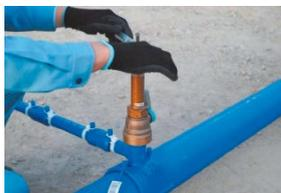
(b) 穿孔機の取付け・穿孔作業
