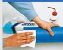
アセトン等を浸み込ませたペーパータオルを使用して融着面を清掃してください。挿入標線を再度記入してください。
