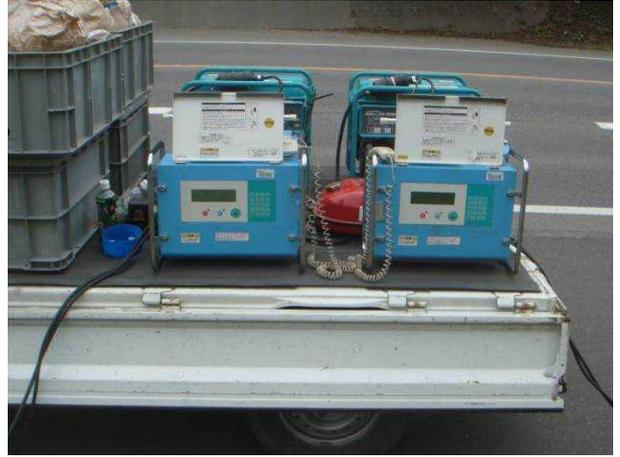
国道45号線歩道端布設ではEFコントローラ2台を軽トラックに積んで移動しながら、2箇所毎4分間隔で融着(通電は3分)
