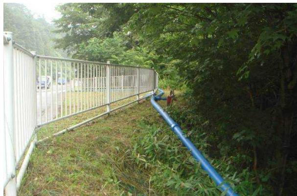
国道45号線法面を生曲げで下の道路に配管
