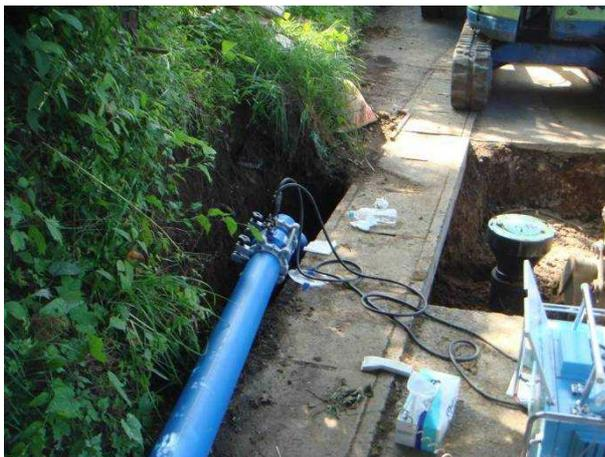
側溝を下越して道路脇に立ち上げ、露出配管で国道下トンネルに沿って横断
