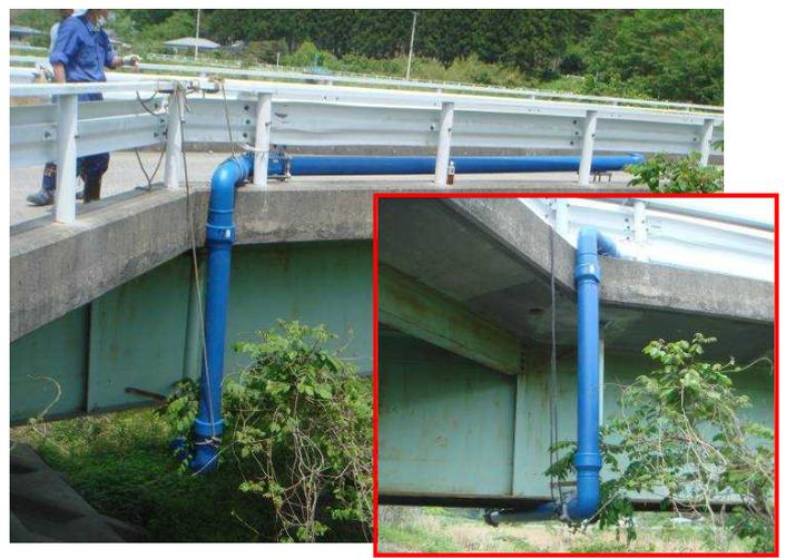
橋の上でバンドと切管をEF接合し、ロープで吊降ろして、上の直管と橋の下横断の直管にEF接続
