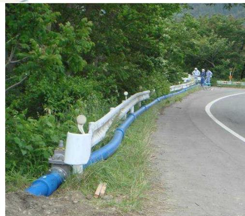
掘削中に道路上で管をEF接続し、人力で生曲げして溝に投入
