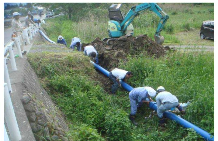
河川敷の駐車場への坂道を掘削して、陸付けしておいた片受直管3本15mを挿入しEF接合
