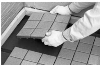
連結部の凹部と凸部を合わせて、パチンと押し込むだけの簡単施工。幅調整材を使用すれば、すき間なくぴったりと納まります。破損した場合も、そのブロックだけを取り替えればOK。メンテナンスも容易です。
