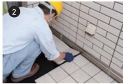
タイルの角を合わせ、連結部分を上からしっかり押さえて設置していきます。
