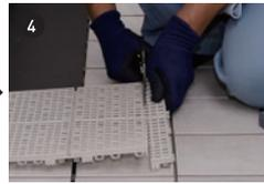
より細かいすき間調整には、プラスチックの幅調整材をカットして納めます。
