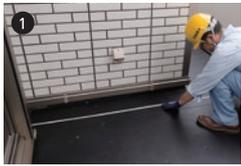
まずはバルコニーの採寸から。細かく寸法を測り、割り付けを決定します。
