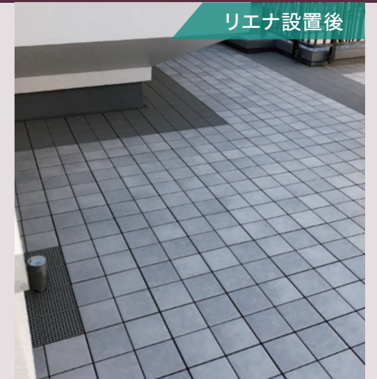
リエナ設置後 ウレタン防水の上にリエナを設置して デザイン性をアップ
